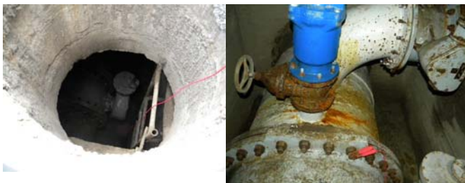
اتصال گیره های دستگاه PL960 به خط ۱۲۰۰ inch
